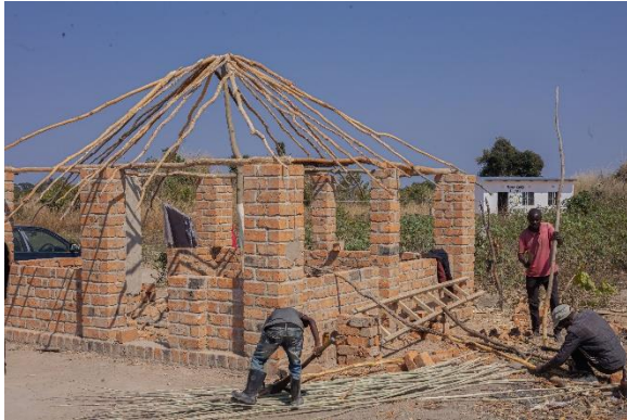
Errichtung des Paillotes
