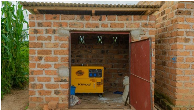
Dieselaggregat (wettergeschützt)
