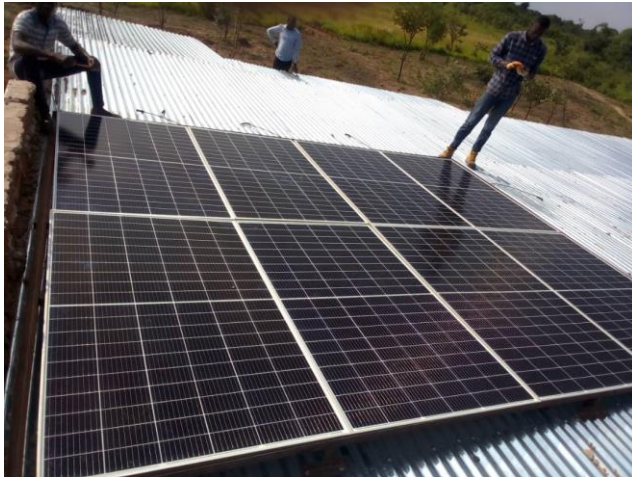
Die Paneelen werden auf dem Dach montiert
