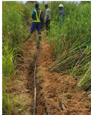
Rohrverlegungen von der Wasserstelle zur Landwirtschaft von Aksanti
